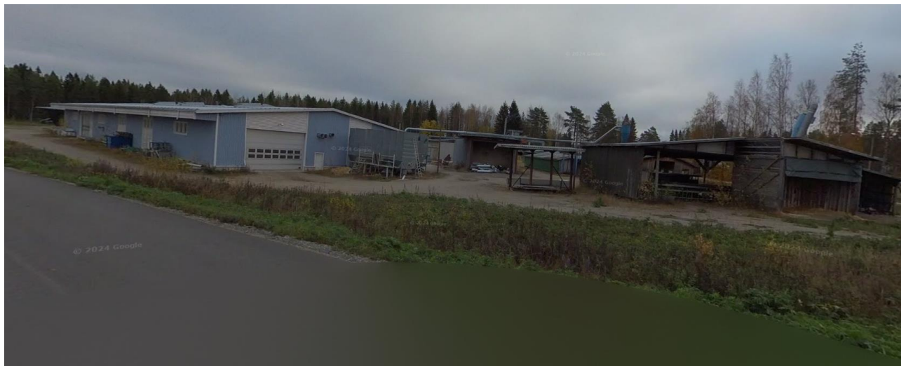
Kuva 14. Korttelin 7 olevaa rakennuskantaa.
