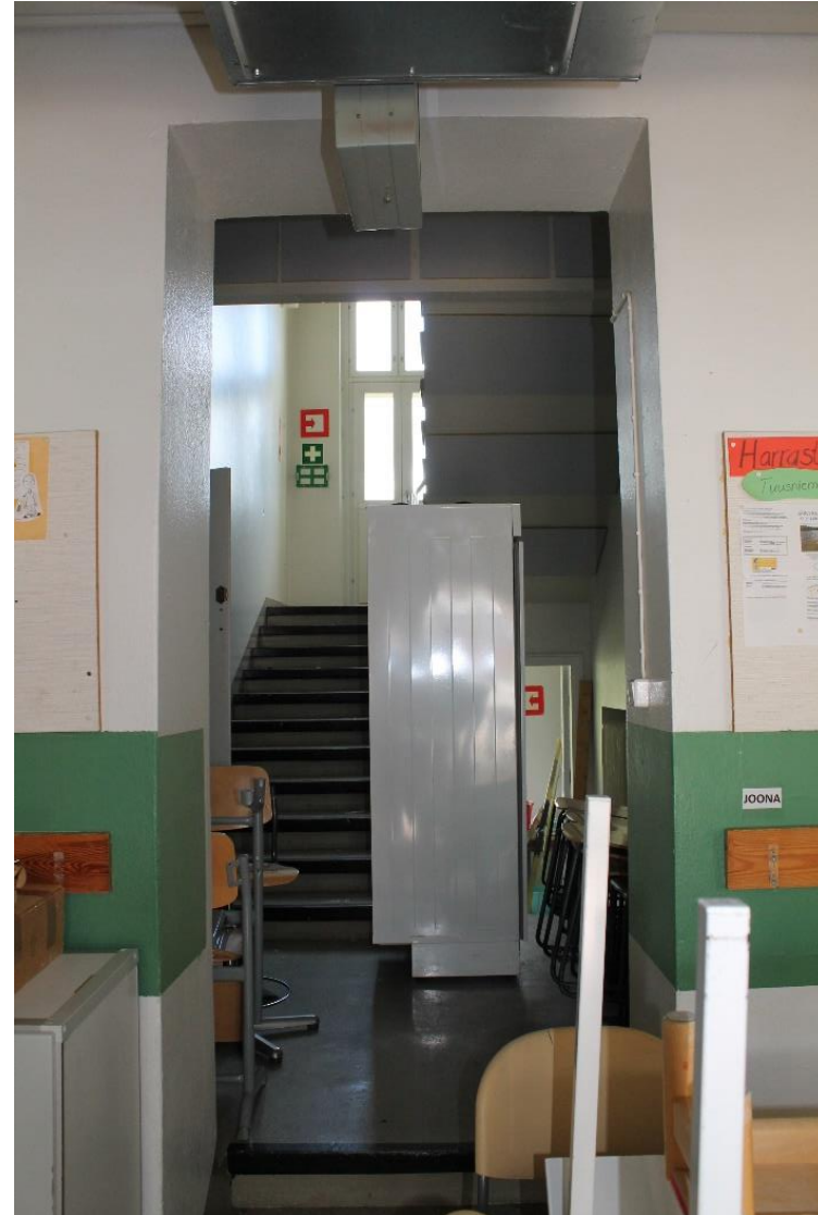
Kuva 92 Porrashuonenäkymä ensimmäisen kerroksen käytävältä.
