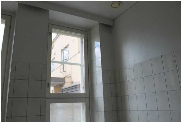
Kuva 179 Suihkutiloista on ikkunat sisäpihalle. Ikkunoiden alaosat on maalattu umpeen estämään suoria näkymiä pihalta suihkutiloihin.
