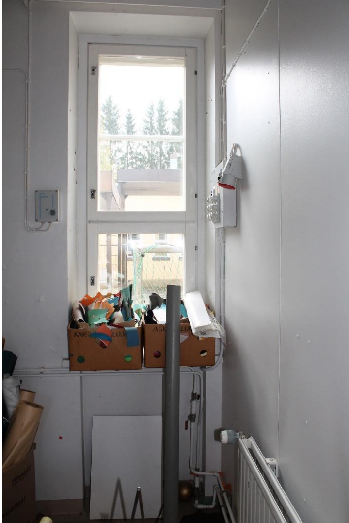
Kuva 185 Entinen opettajainhuone 120. Ikkunasta on näkymä siipiosien väliin jäävälle "sisäpihalle".
