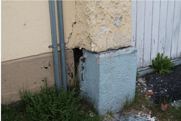
Kuva 59 Takajulkisivun sisäänkäynnin detalleja. Rappaus oven reunuksen ympärillä on ollut karkeampi kuin seinillä.
