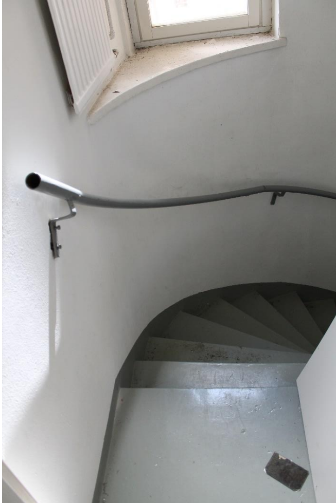
Kuva 191 Siipiosan portaikon jyrkät betonirakenteiset portaat. Siipiosan portaikko vie kellarin lämmönjakuhuoneeseen ja vanhaan sähköpääkeskukseen.
