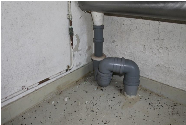
Kuva 272 Pisoaarin muoviputkia.
