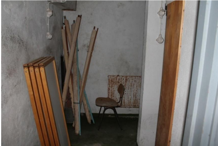
Kuva 299 Näkymä kellarin sähköpääkeskuksen suuntaan. Kellarin käytävälle on sijoitettu opetustarvikkeita ja kalusteita.
