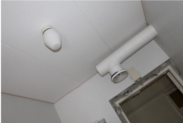
Kuva 256 Opettajanasunnon 1 eteisen katossa oleva valaisin ja ilmanvaihtoputki. Katossa on myöhemmin tehty panelointi.
