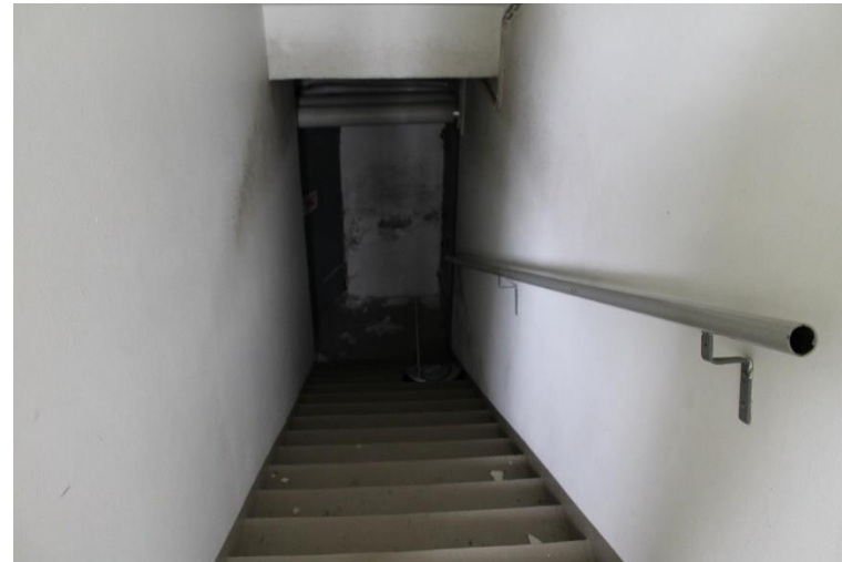
Kuva 282 Rakennuksen keskiosan porrashuoneesta kellariin johtavat portaat.
