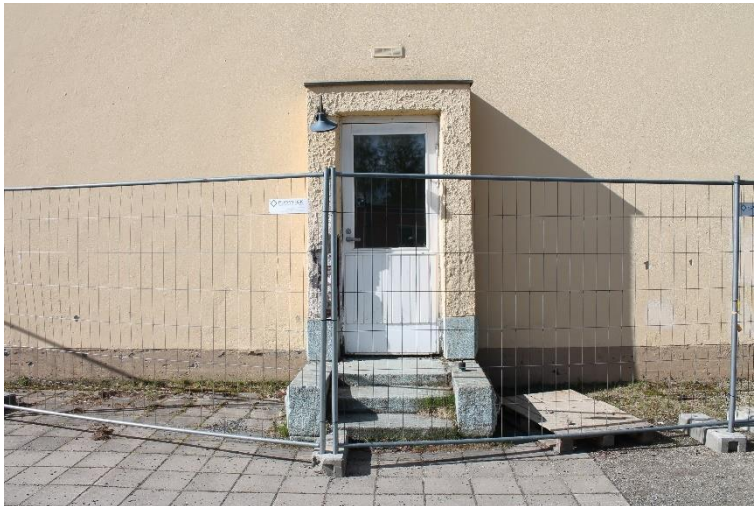
Kuva 60 Sisäänkäynti luoteiseen siipiosaan. Myös siipiosien ovia kehystää ulkoneva reunus, jossa rappaus on karkeampi kuin muualla seinillä korostamassa sisäänkäyntiä.
