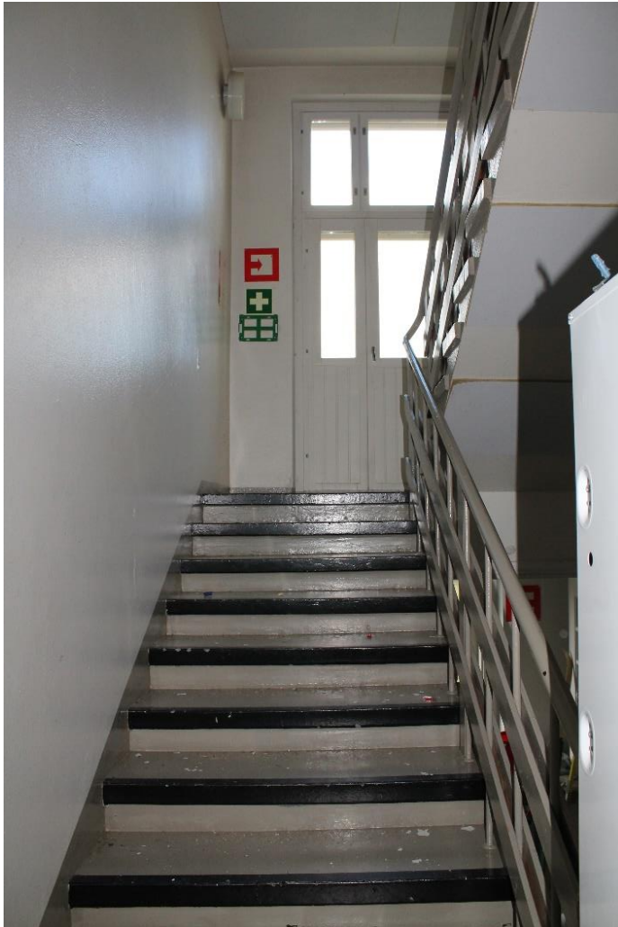
Kuva 198 Näkymä rakennuksen keskiosassa sijaitsevasta portaikosta kohti toista kerrosta. Kuvassa näkyvä ovi johtaa kerrosten välillä olevalle tuuletusparvekkeelle.
