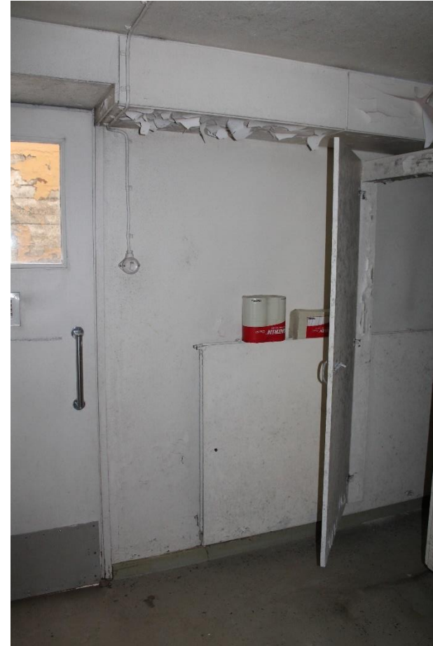
Kuva 275 Tyttöjen vessan seinässä on patteri ja koteloituja putkia.
