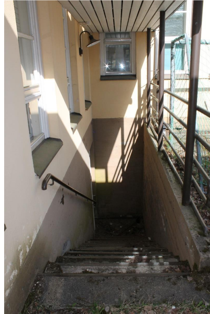
Kuva 65 Portaat kellarikerroksen poikien vessan ovelle.
