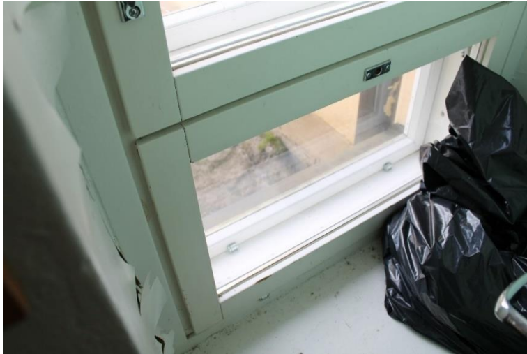
Kuva 101 Käytävän pystysuuntaisten ikkunoiden alaosassa on matalat tuuletusosat.
