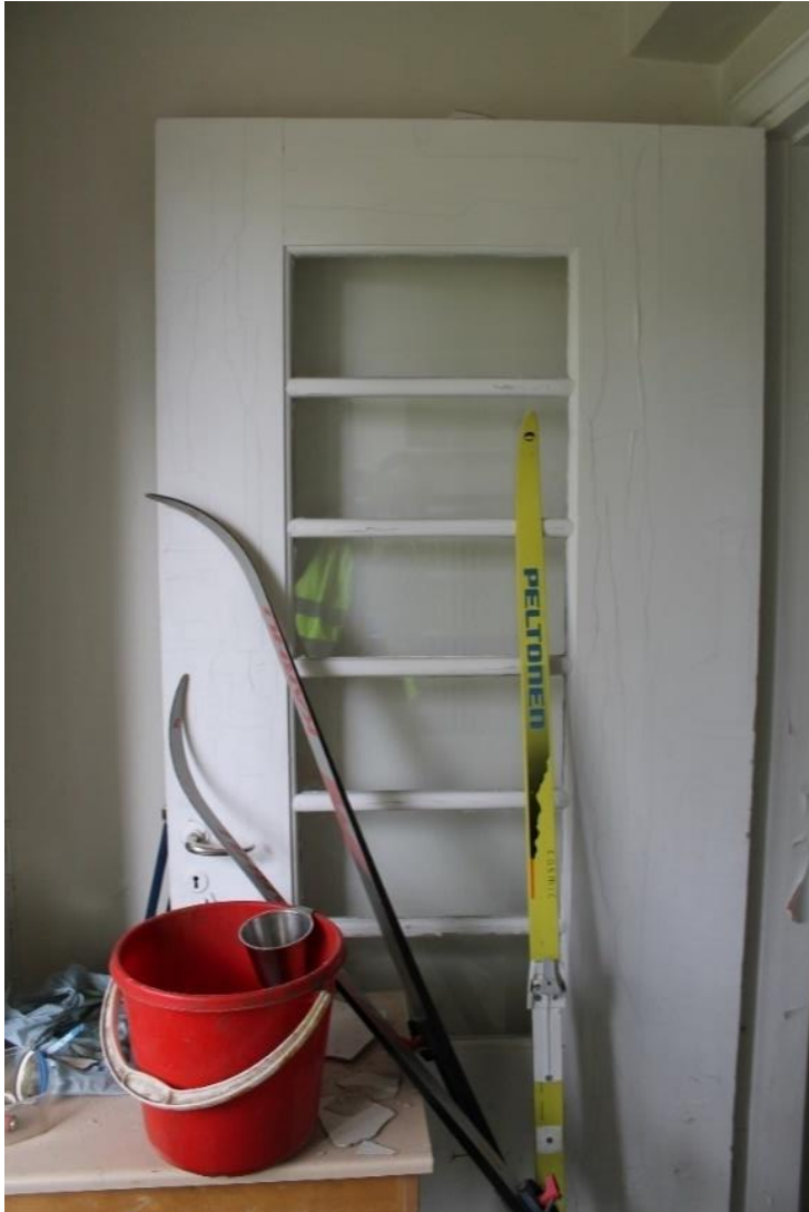
Kuva 140 Porrashuoneen tuulikaapin ikkunallinen puuvi on mallinsa perusteella alkuperäinen. Myös kahva ja lukko vaikuttavat alkuperäisiltä.
