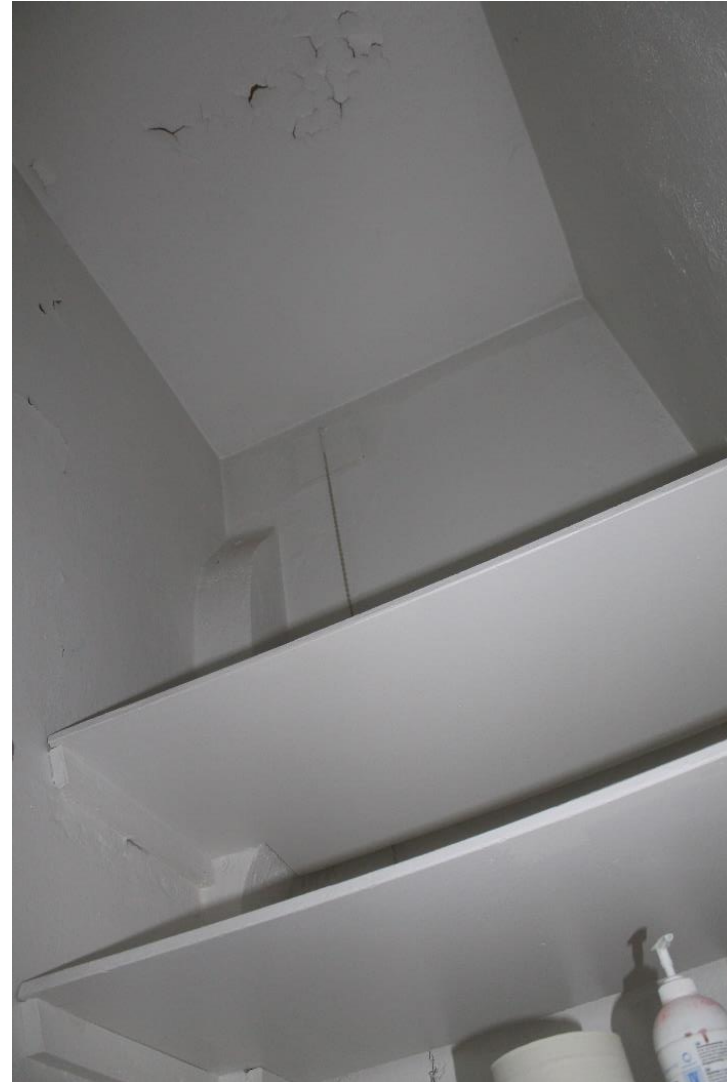
Kuva 118 WC-tila on korkea tilaa, huoneen yläosassa on säilytyshyllyjä.
