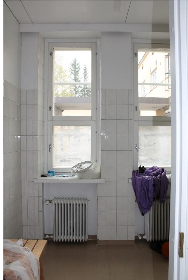
Kuva 177 Etiseen opettajainhuoneeseen 120 on rakennettu jälkeen päin suihkutilat.
