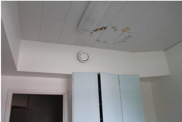
Kuva 233 Opettajanasunnon 2 keittiössä ilmanvaihtoputket on koteloitu.
