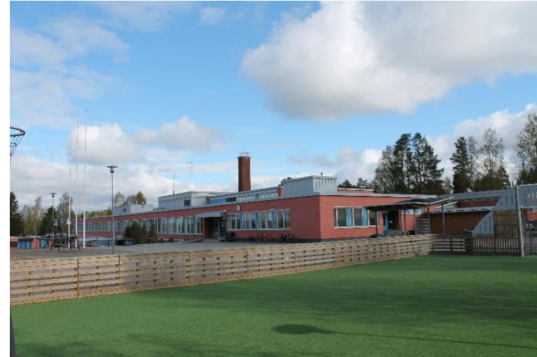
Kuva 21 Tuusniemen yhtenäiskoulun 1960-luvulla rakennettu osa. Koulun arkkitehtuuri on hyvin pelkistettyä ja vaakaelementtejä painottavaa.
