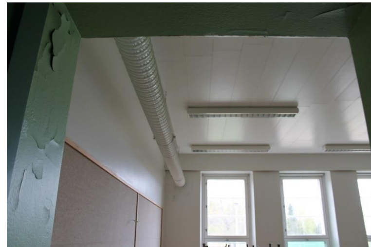
Kuva 161 Ilmanvaihtoputki luokkahuoneen katossa. Osassa luokkahuoneita katto on paneloitu myöhempien muutosten yhteydessä.
