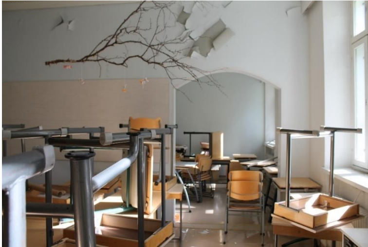
Kuva 105 Luokkahuoneen 107 takaseinään on puhkaistu aukko tilaan, joka on alun perin toiminut terveydenhoitajan vastaanottotilana.
