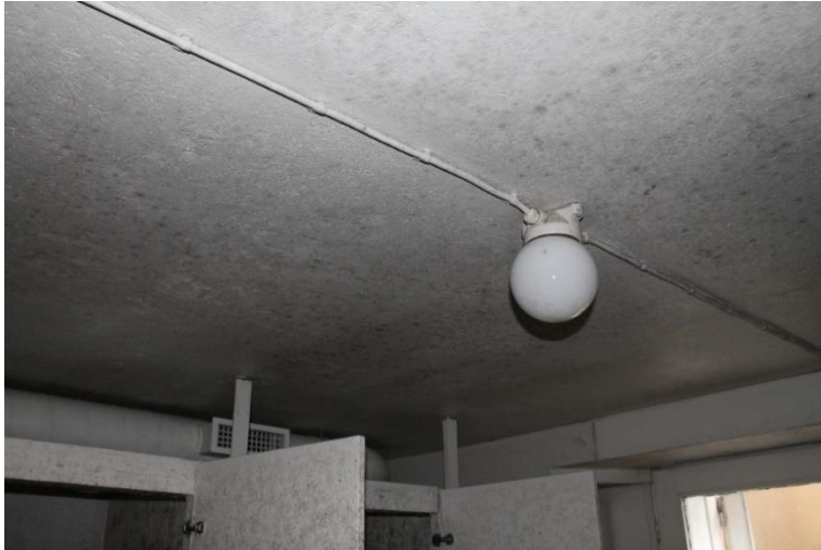
Kuva 278 Tyttöjen vessan katossa oleva valaisin.
