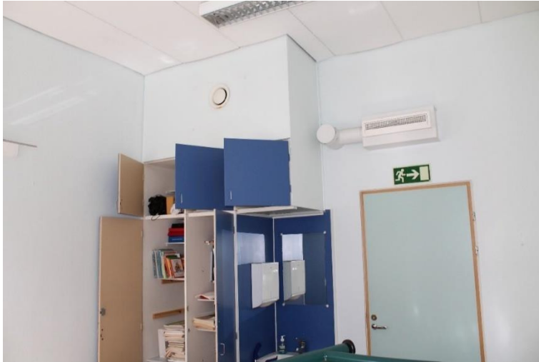
Kuva 109 Entisessä vastaanottotilassa on vesipiste ja kiinteää kaappitilaa.
