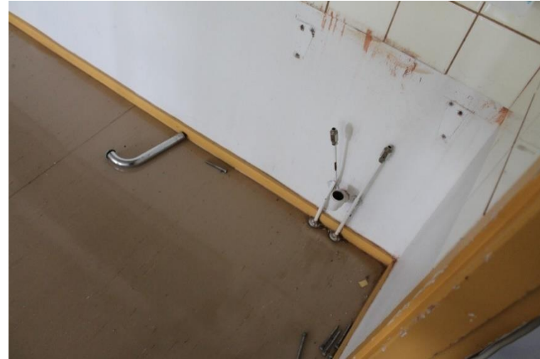
Kuva 216 Vanha vesipisteen paikka kieliluokan nurkassa.
