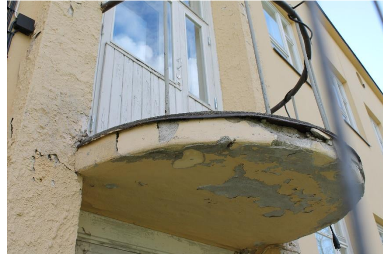
Kuva 76 Etelän puolella sijaitsevan parvekkeen alapinta. Siro parvekelaatta on n. 15 senttimetriä paksu, mikä on ollut aikakauden rakentamiselle tyypillistä.
