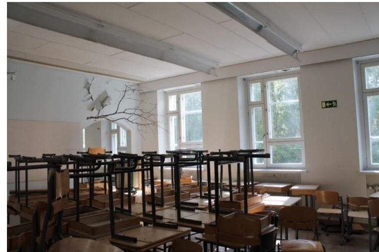
Kuva 104 Luokkahuone 107 ensimmäisen kerroksen käytävän kaakkoispädyssä matalan siiven keskiosassa.
