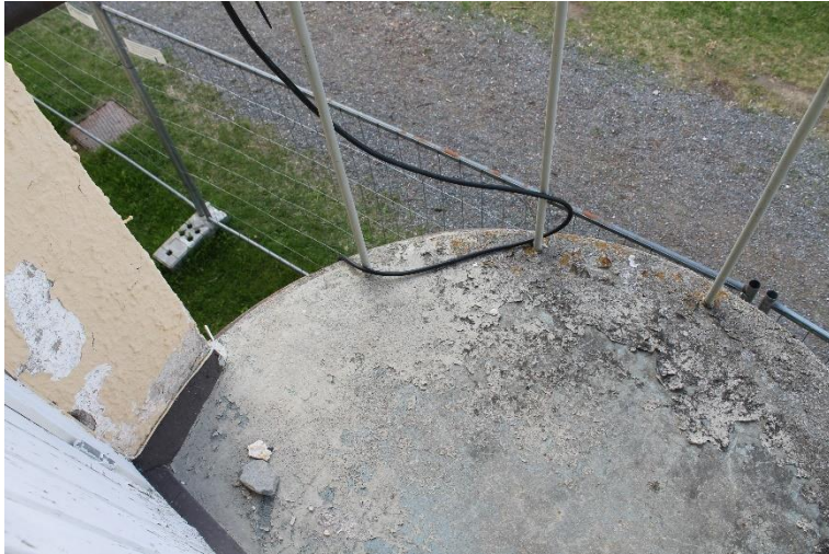
Kuva 78 Parvekkeen lattiapinta on paljasta betonia. Kuvassa näkyy myös kaidepinnojen sirous sekä harva välitys, joka on ollut aikakaudelle tyypillistä.
