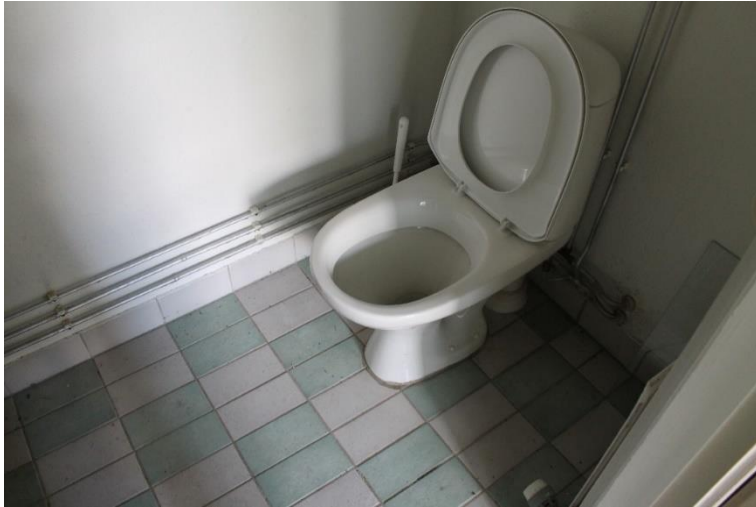
Kuva 116 Tuulikaappia vastapäätä sijaitseva WC-tila.
