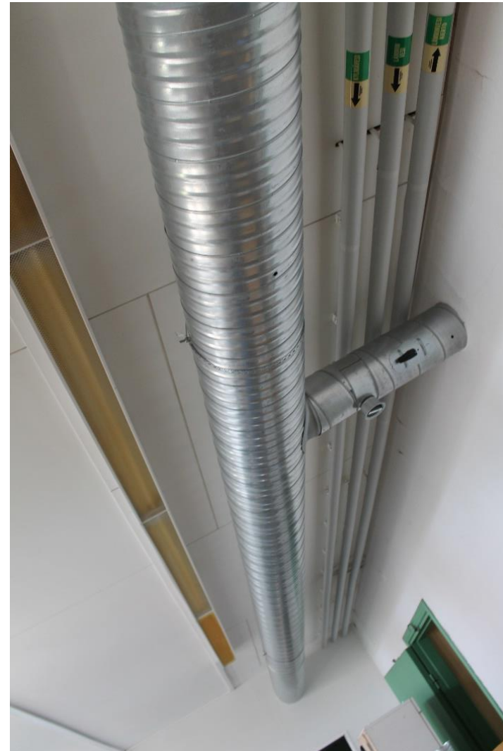
Kuva 95 Käytävän katossa on esillä ilmanvaihtoputket ja vesijohdot.
