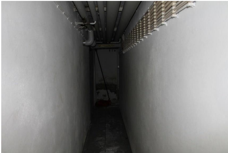
Kuva 294 Käytävänäkymä lämmönjakohuoneesta porrashuoneelle ja talouskellarille päin.
