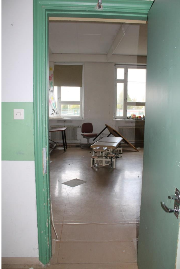
Kuva 152 Useilla luokkahuoneilla on ajan saatossa ollut erilaisia käyttötarkoituksia. Kuvassa näkyvä luokkahuone 112 on ollut vuoden 2005 pohjapiirustusten mukaan esimerkiksi kansalaisopiston kuvataidetoimintatilana, ja kalusteista päätellen tilassa on toiminut myös hieroja.
