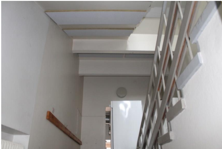
Kuva 144 Portaiden alapintaan on kiinnitetty äänenvaimennuslevyjä.
