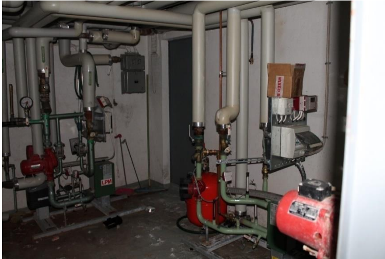
Kuva 293 Koulun lämmönjakokeskus.
