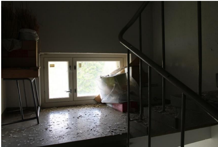
Kuva 303 Ullakolle vievä porrastasanne. Tasanteella on matala tuuletusosallinen vaakasuuntainen ikkuna.
