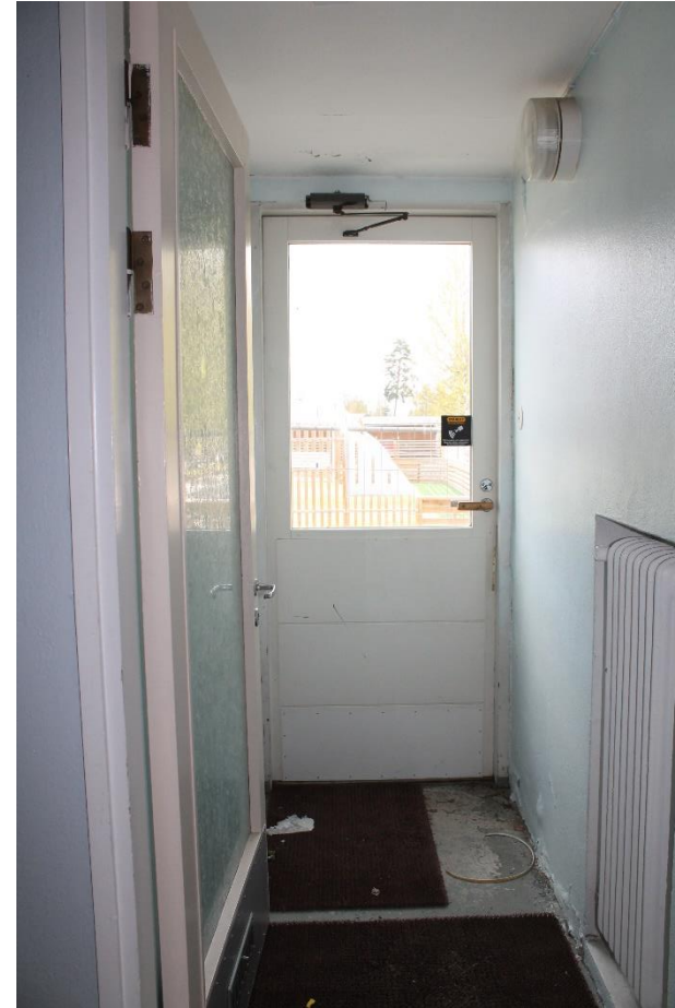
Kuva 113 Kaakon puolella sijaitsevan siiven sisäänkäynti. Tuulikaapissa on seinässä syvennys patteria varten. Ulko-ovi on uusittu.
