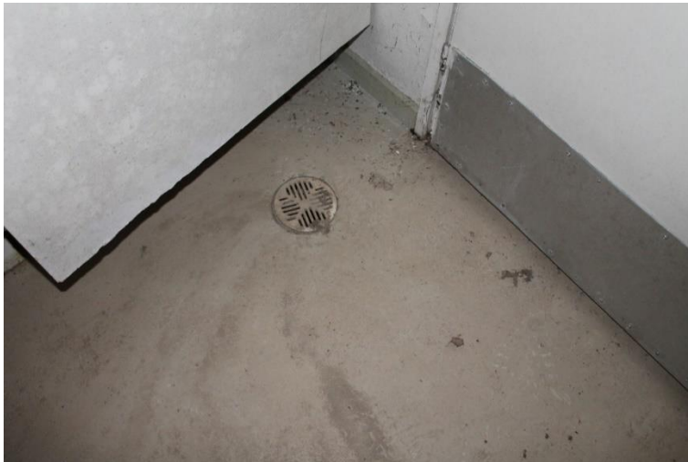
Kuva 281 Betonilattiassa oleva viemäri.
