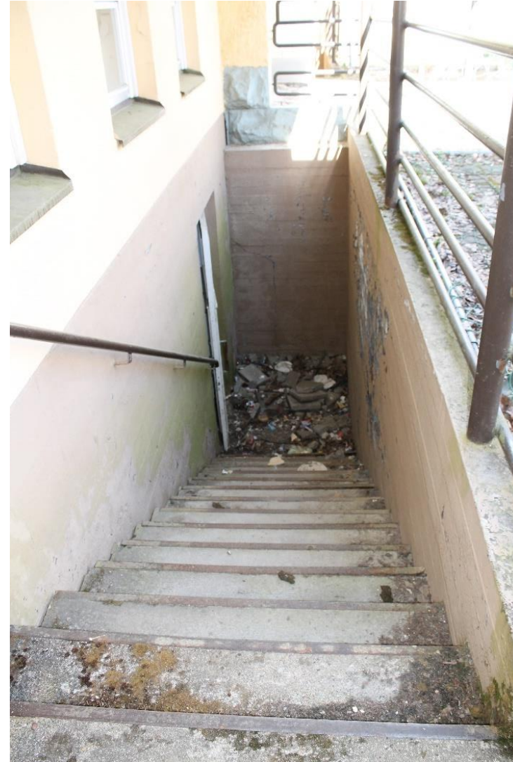
Kuva 273 Portaat tyttöjen saniteettitiloihin.
