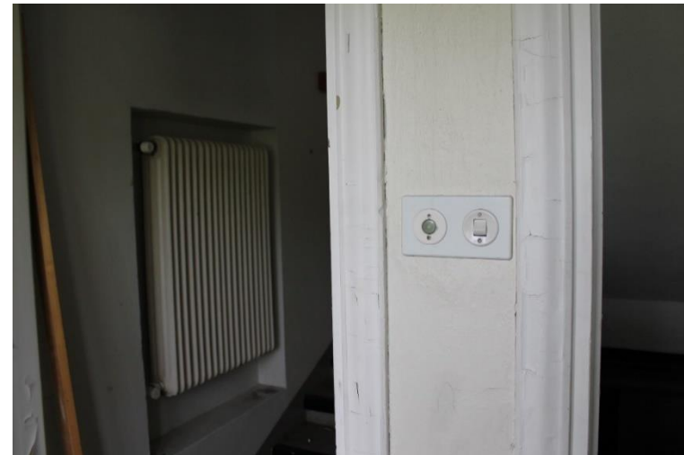
Kuva 139 Porrashuoneen tuulikaapissa on ovikello ja valokatkaisin.
