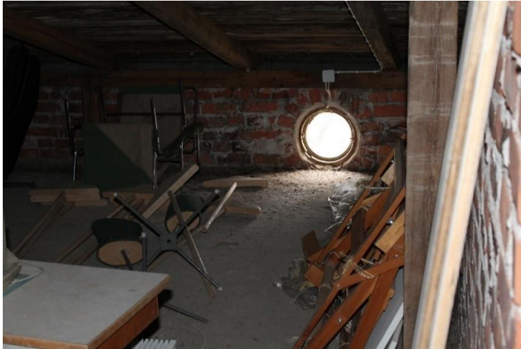
Kuva 309 Ullakolla on pyöreitä ikkunoita. Ikkuna-aukko on muurattu pyöreäksi tiilistä.
