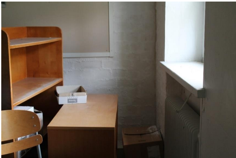
Kuva 131 Luokkahuoneen 108 takaseinä on muurattu tiilistä. Tiilet ja laastisaumat erottuvat ohuen rappauksen läpi selvästi.
