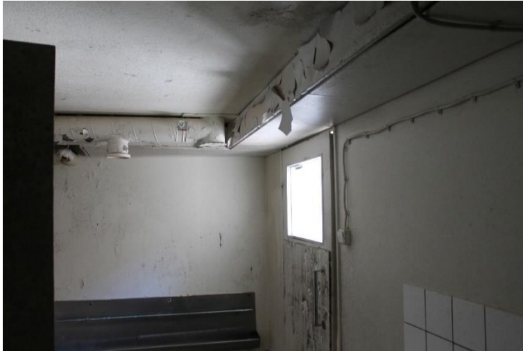
Kuva 271 Poikien vessan sisäänkäyntioven yläosassa on lasiruutu.
