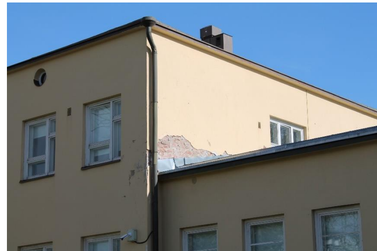
Kuva 74 Matalan siipiosan liittyminen korkeampaan rakennusosaan.
