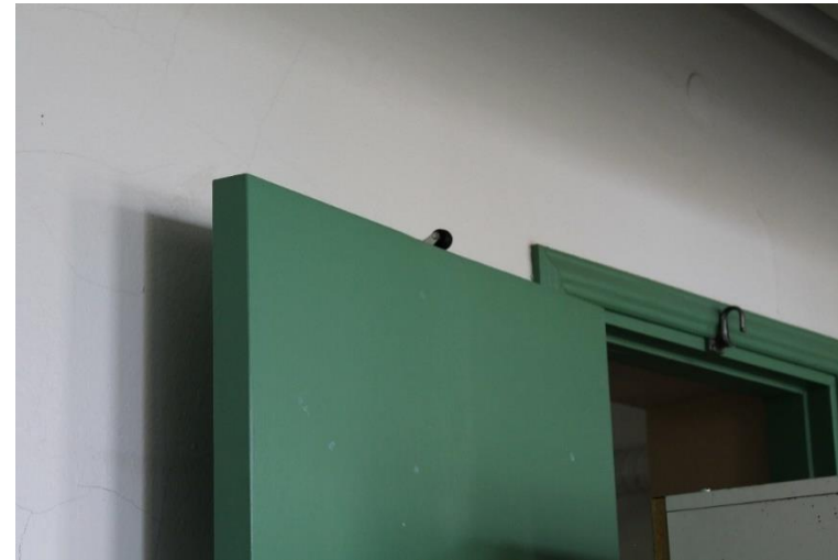
Kuva 103 Luokkahuoneen vihreäksi maalattu puuovi ja oviaukon listoitut.
