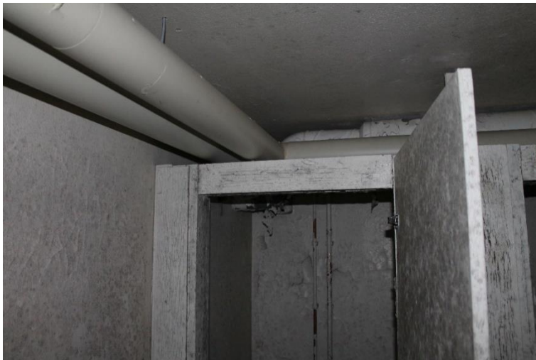
Kuva 268 Vessakopin rakenteita ja ovi.
