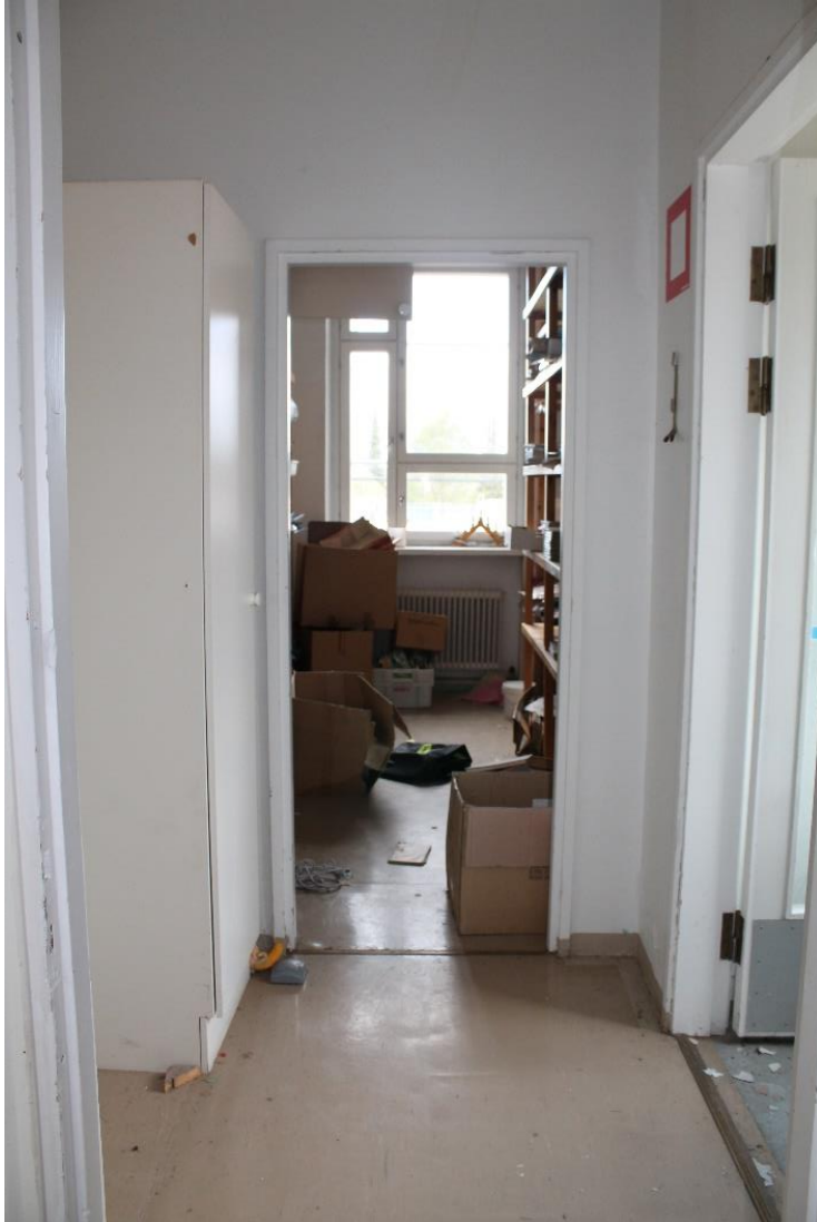
Kuva 182 Näkymä tuulikaapin läpi entiseen vahtimestarin asuntoon rakennuksen pohjoisimmassa nurkassa.
