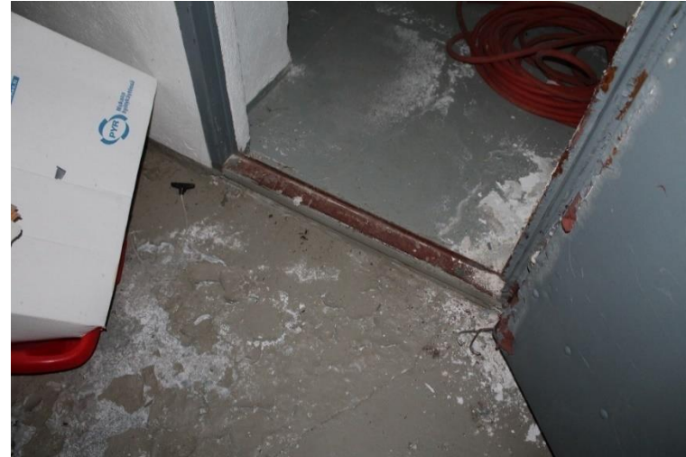
Kuva 285 Kellarin tilojen välisen teräsoven kynnyks.
