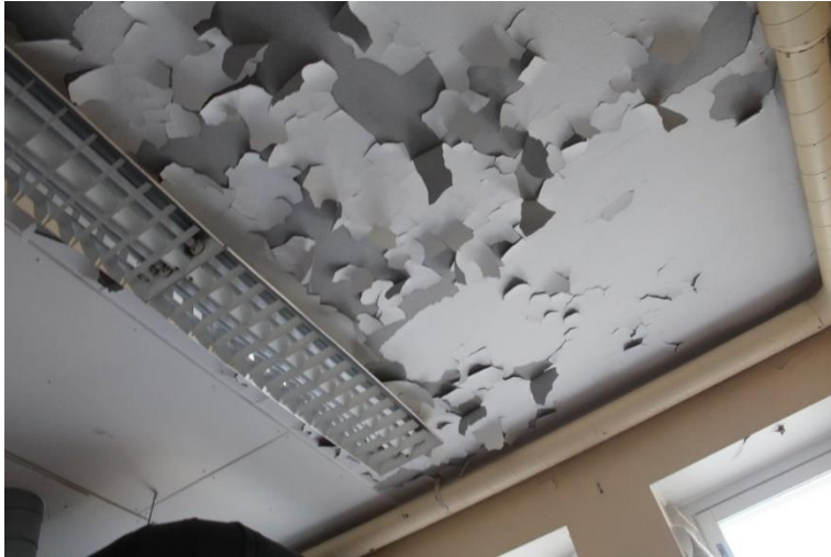
Kuva 196 Vanhan opetusvälinevaraston sisäkattoa.
