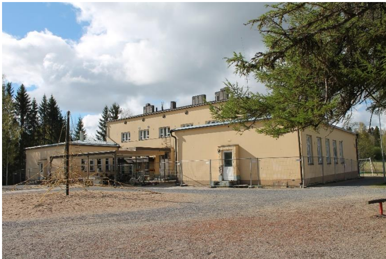
Kuva 48 Rakennusmassa kuvattuna etuviistosta.
