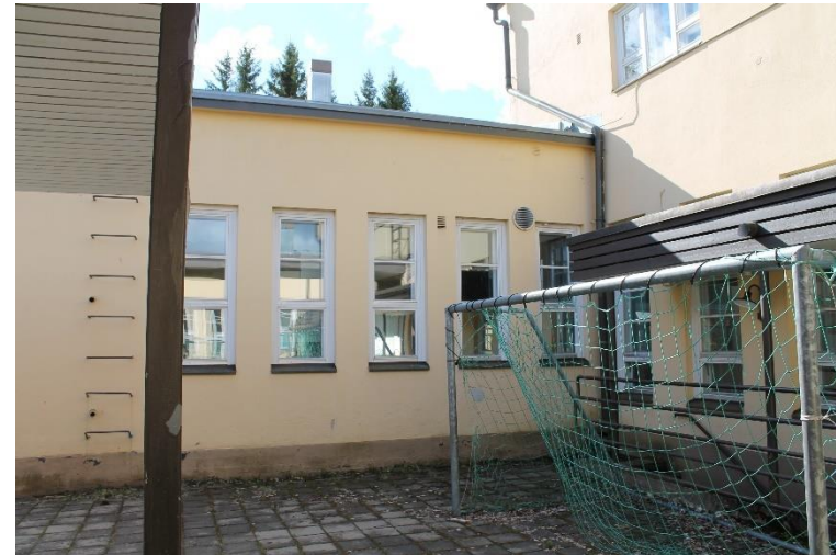
Kuva 84. Kuva rakennuksen sisäpihalta, keskellä yksikerroksisen siipiosan kapeita ja korkeita ikkunoita.
