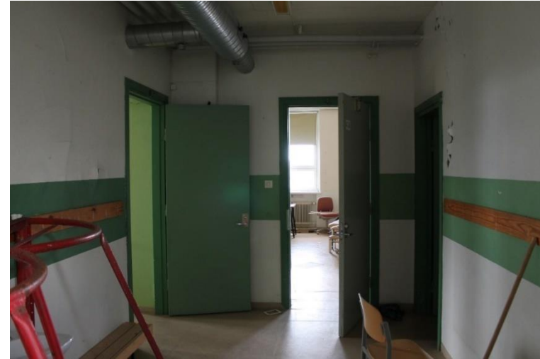
Kuva 151 Ovet käytävän luoteispäässä sijaitseviin luokkiin.
