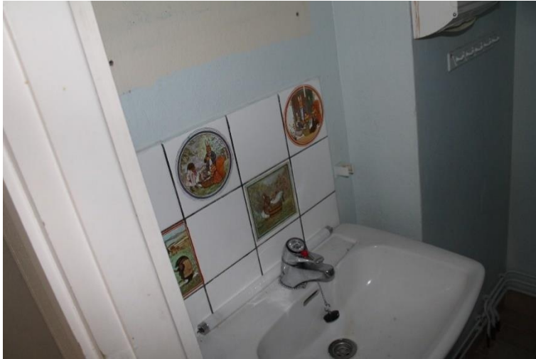
Kuva 229 WC-tilan lavuaarin takana on koristeelliset kaakelit.
