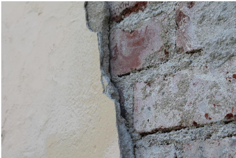
Kuva 52 Tiiliseinän päällä oleva rappauskerros on noin sentin paksuinen.
