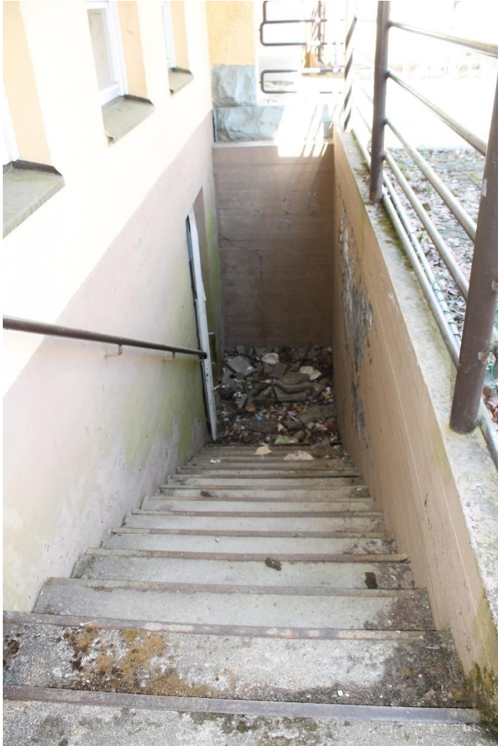
Kuva 66 Portaat kellarikerroksen tyttöjen vessan ovelle.
