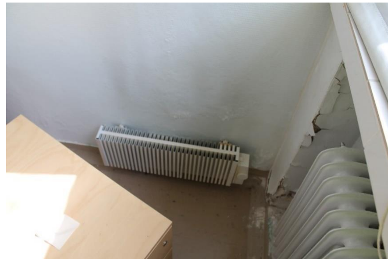
Kuva 108 Entisen vastaanottotilan nurkassa on pieni erillispatteri. Kuvan oikeassa reunassa näkyy ikkunan alle syvennykseen sijoitettu keskuslämmityspatteri.
