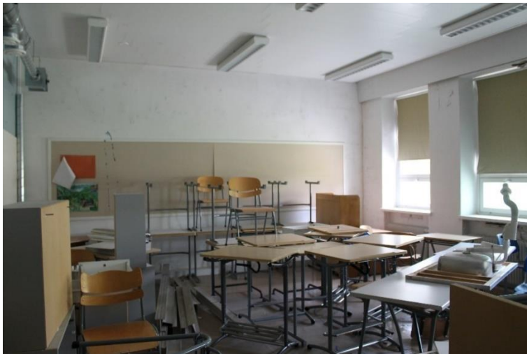
Kuva 127 Rakennuksen etelänurkassa sijaitseva luokahuone 108.
