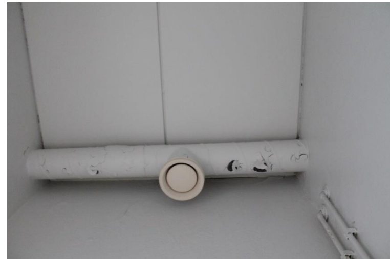
Kuva 175 WC-tilan katossa kulkee ilmanvaihtoputki.
