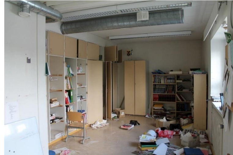
Kuva 209 yläkerran koillissivulla sijaitsevasta keittiöstä on purettu väliseinä, yhdistäen keittiön viereiseen opettajanhuoneeseen. Opettajanhuone on alun perin ollut isoimman opettajanasunnon makuuhuone.
