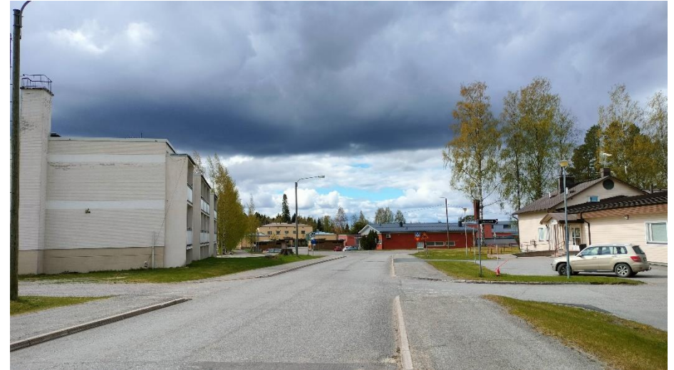
Kuva 29 Näkymä Harjutieltä vanhalta terveystalolta kohti Tuusniemen vanhaa kansakoulurakennusta. Kuvan vasemmassa laidassa 1970-luvulla rakennettu kerrostaloyhtiö, ja oikeassa laidassa jälleenrakennuskaudella rakennettu nykyisin terveyskeskuksena toimiva rakennus.
