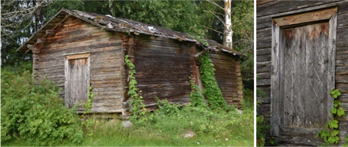
KUVAT 28 ja 29: Pajukannan pihapiiriä, ylhäällä. Vasemmalla Pajukannan pihapiirin pariasta. Oikealla asuinrakennuksen puoleisen aitan vinoruutukoristeinen päätyovi.
